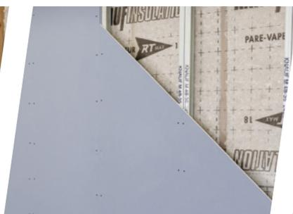
L'isolant est inséré entre les montants. Le pare-vapeur, obligatoire, sera positionné directement sur l'isolant ou sur l'ossature métallique.
