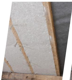
Mise en place aisée en rampants grâce à la légèreté des panneaux.
