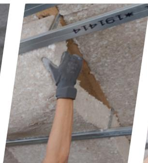
La flexibilité permet une mise en place au travers de l'ossature.
