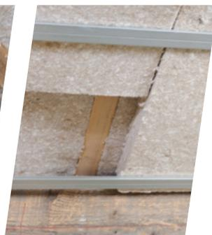
Recouvrement des chevrons pour éviter les ponts thermiques.
